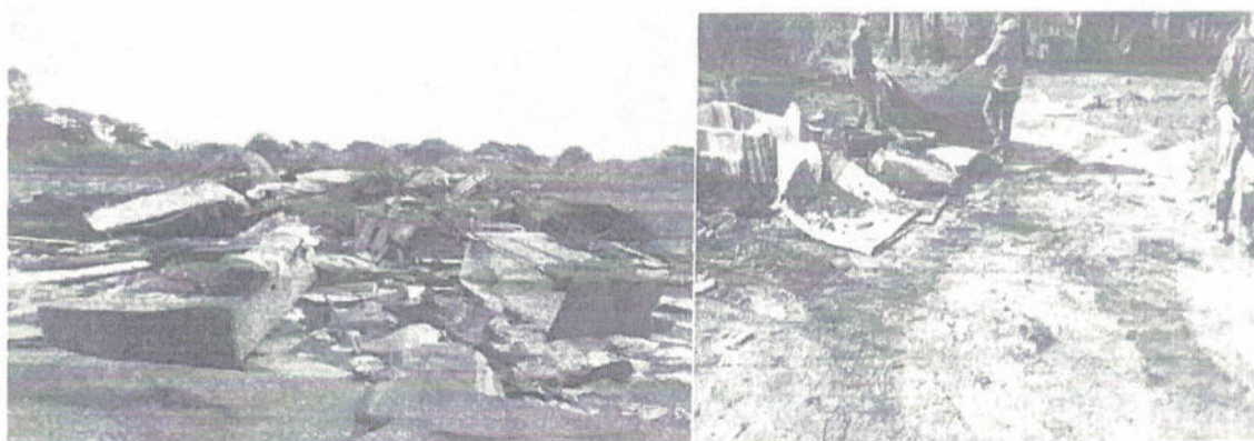
Figura 4. Pátio de triagem de resíduos sólidos urbanos. Nas fotografias observa-se a separação dos resíduos que foram alocados sobre o piso existente nesta unidade, até que seja concluída contratação de empresa especializada para a destinação final.
